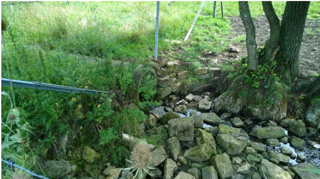
Abbildung 9: Steinschüttung zur Ufersicherung und Rohrdurchlass zwecks Überfahrt am insgesamt mäßig ausgebauten Bachabschnitt (Schampeschbaach)
